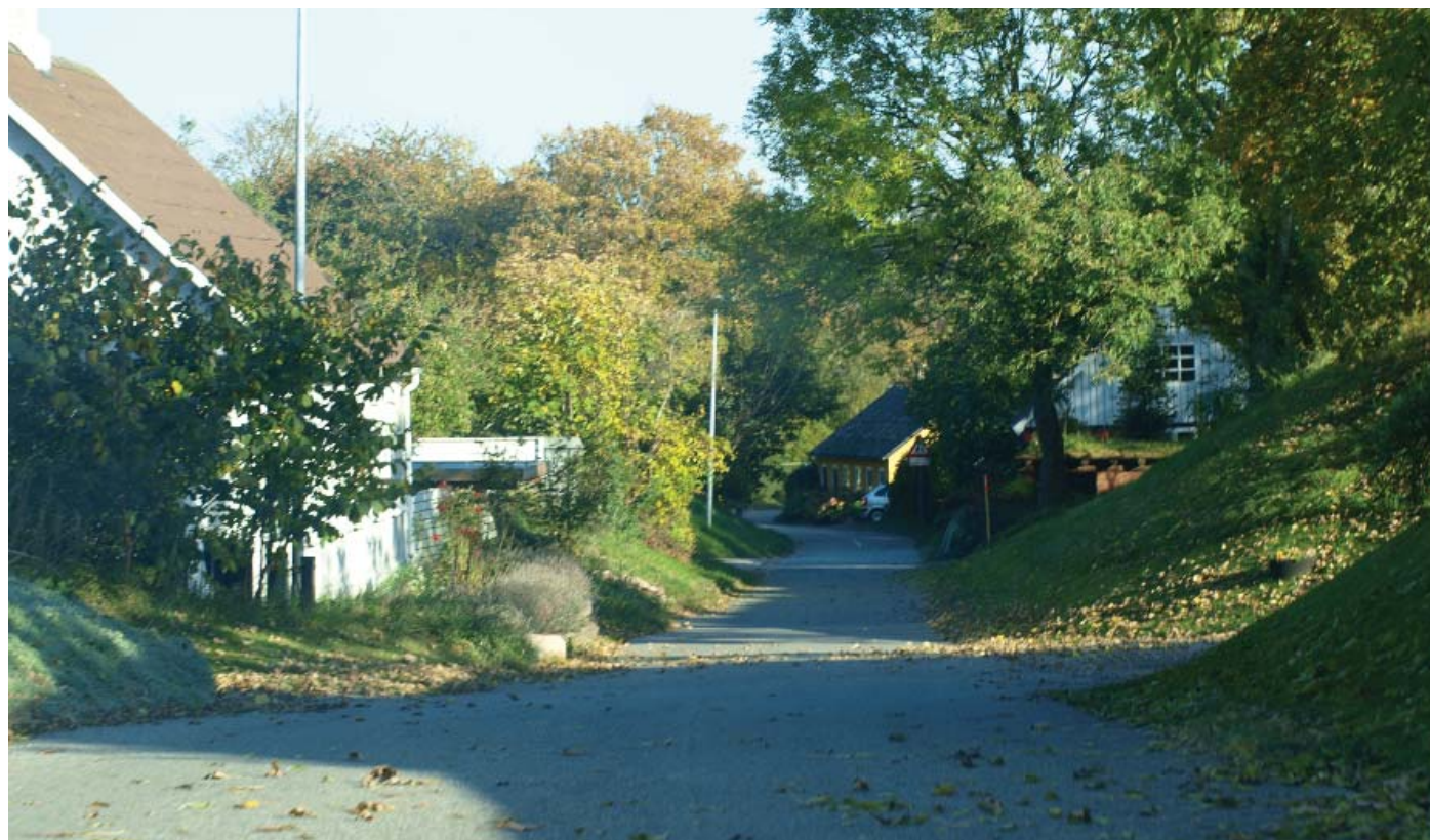
Typisk længehus med 45° saddeltag og facaden vendt ud mod landsbygaden
