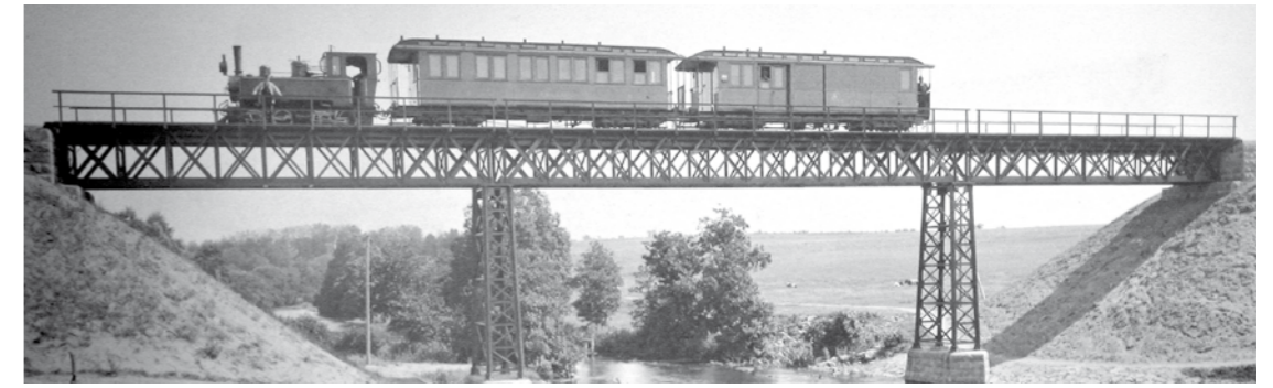
Højbroen i jerngitterkonstruktion fra 1899.
