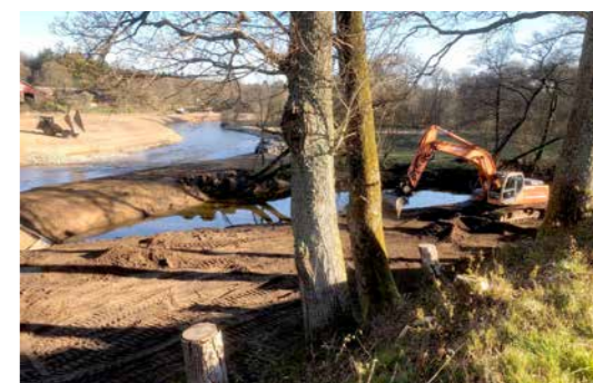
Riværket i Klosterkær april 2020.
